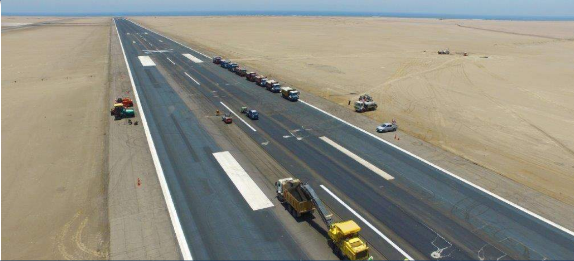
Proceso de Fresado de Pista para su reutilización en RESA y Caminos Perimetrales
