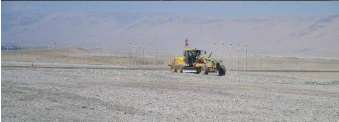
Perfilado de Terraplén
