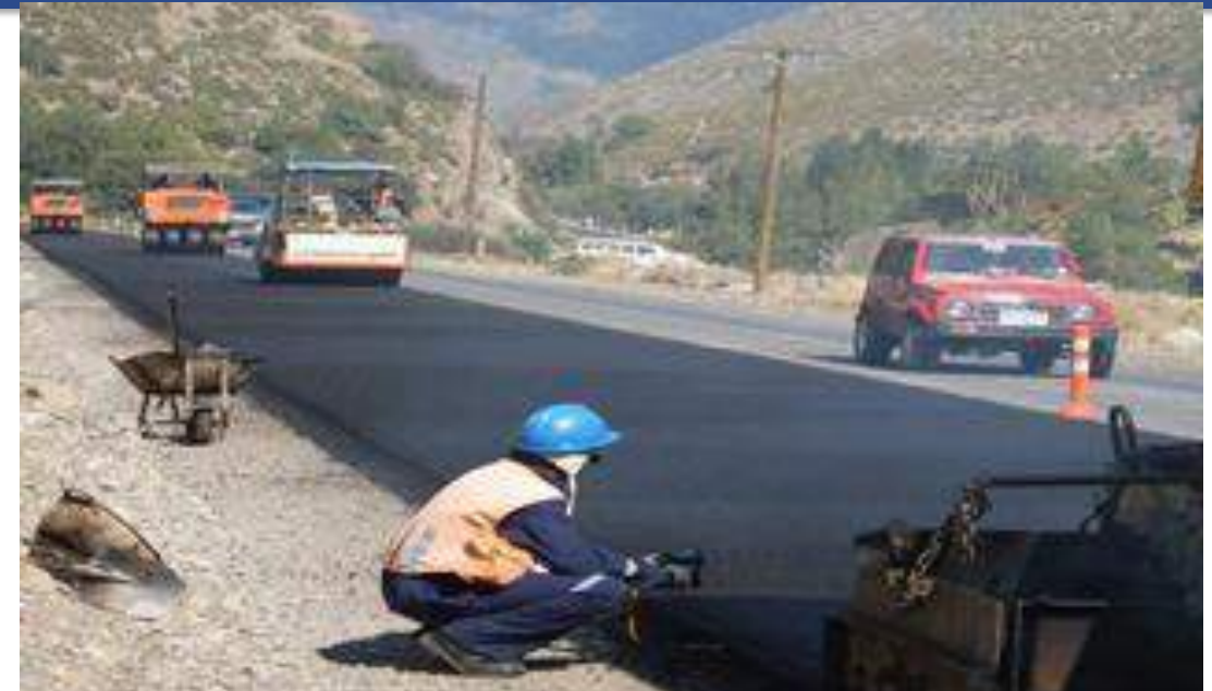
Tramo Experimental Ruta 60-CH, Región Valparaíso
