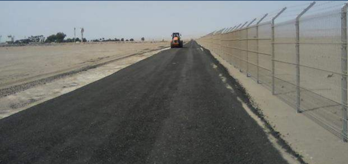
Camino Perimetral Material fresado Reutilizado
