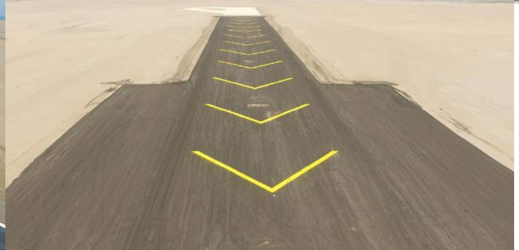
RESA(área de seguridad extremo de Pista) con Material fresado Reutilizado
