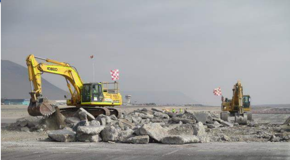
Remoción Pavimento Hormigón
