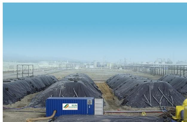
**Proceso de descontaminación, técnica biopilas**
